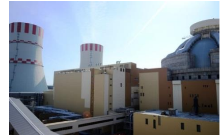
Russia, Novovoronezh NPP II, Unit 1 - 1200 MW
